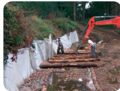
Réalisation d'un caisson végétalisé sur le Sornin
