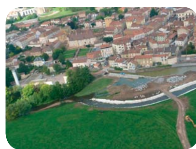
Détournement temporaire du Sornin pour reconstruire le seuil des pompiers à Charlieu
